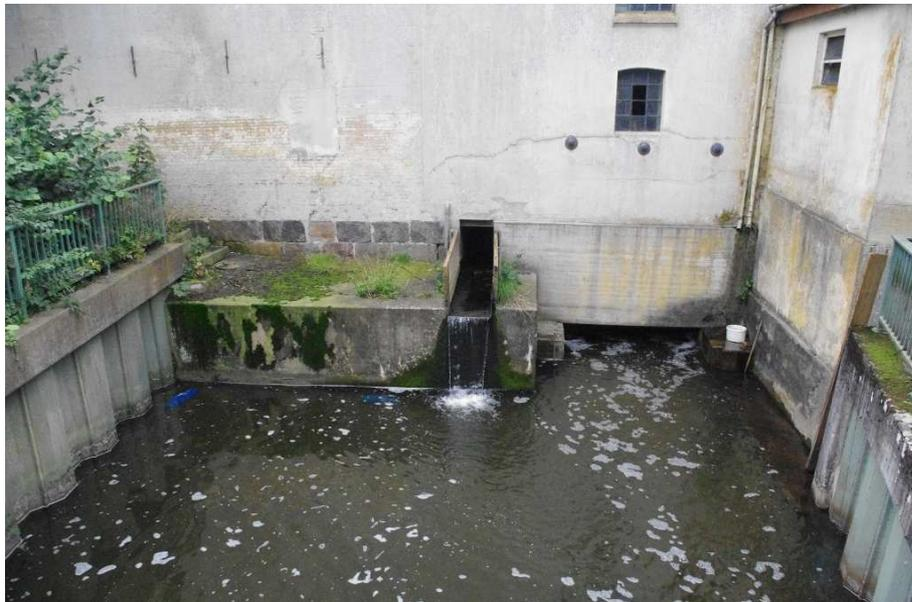
Abbildung 2: Ansicht der Mühle in Wellspang. Im Vordergrund befindet sich das Tosbecken (Radkuhle), an der linken Seite ist der Auslauf der Turbine des Kleinwasserkraftwerks erkennbar. Die Krebse gelangen über den Überlauf in der Bildmitte in das Oberwasser.
