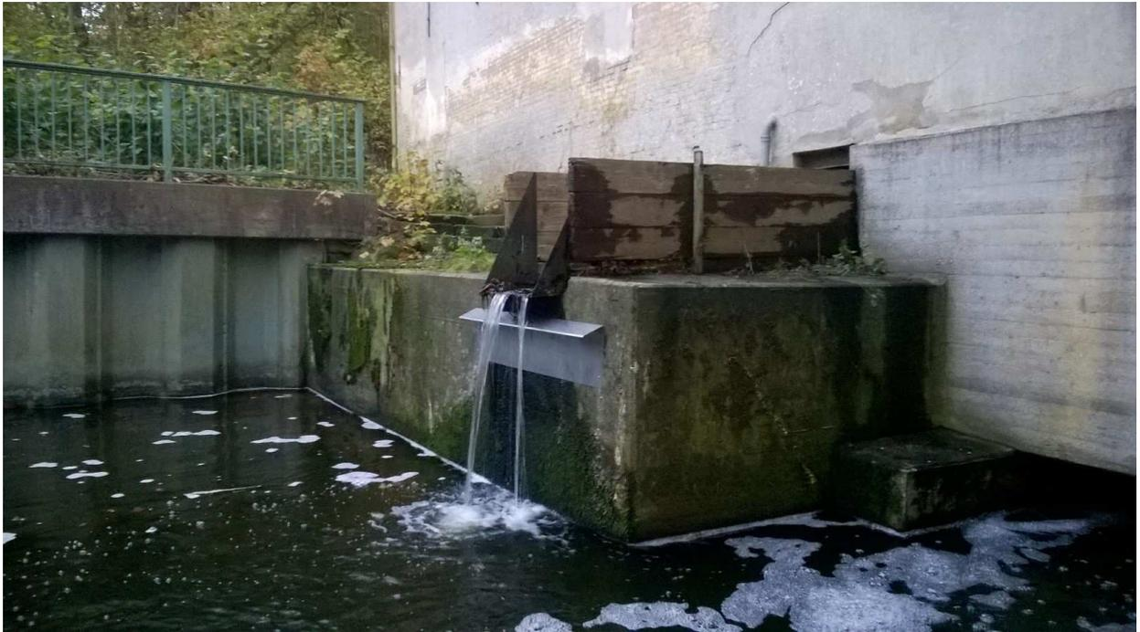
Abbildung 11: Das neu installierte Stahlblech verhindert durch das abgekantete obere Teil auch bei stärkerem Bewuchs ein Überklettern durch Flusskrebse.
